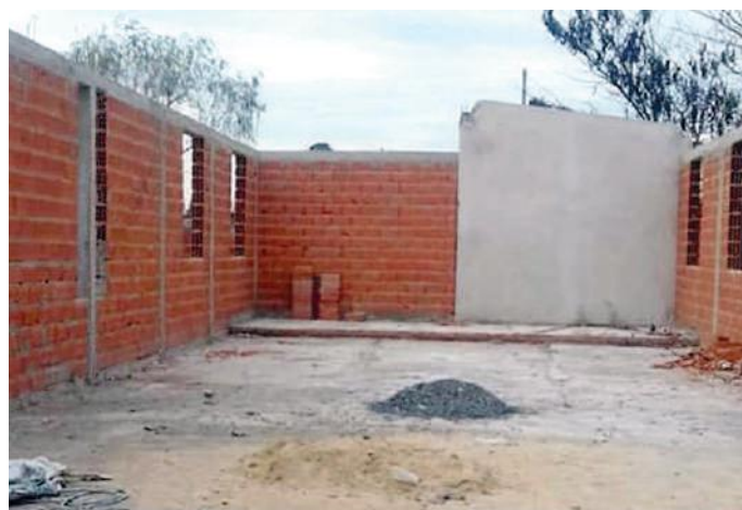
Il salone in costruzione in Argentina
