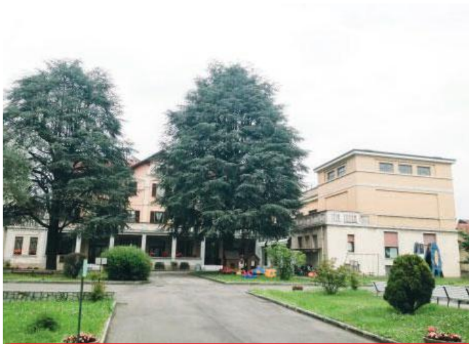
Il complesso di via Montello dell'istituto Pozzi
