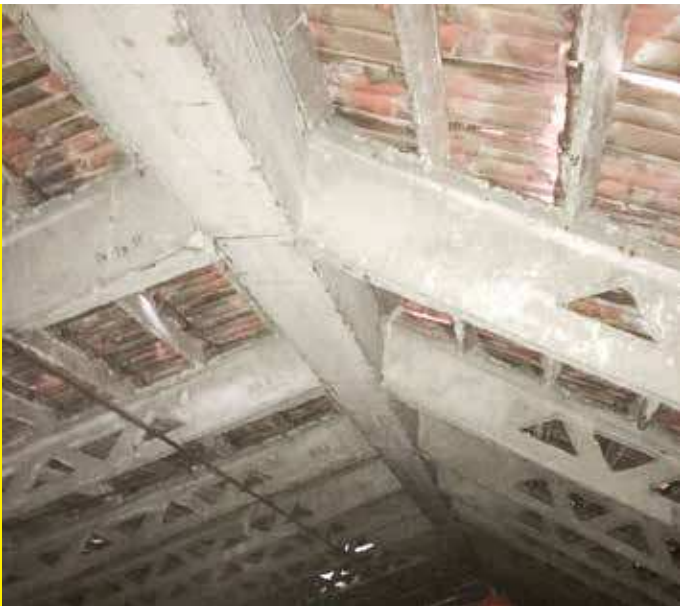
Lo stato di deterioramento del tetto
