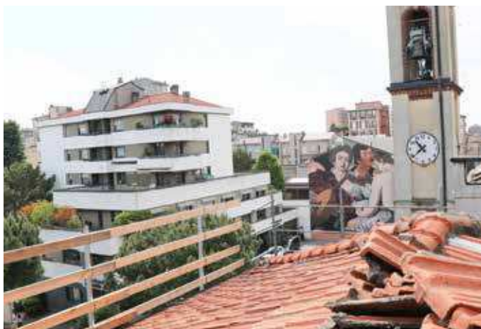
I lavori sul tetto dell'oratorio San Rocco
