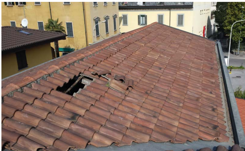
Il tetto del complesso dell'abbazia che necessita di urgenti interventi
