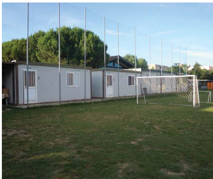
I prefabbricati che saranno sostituiti
