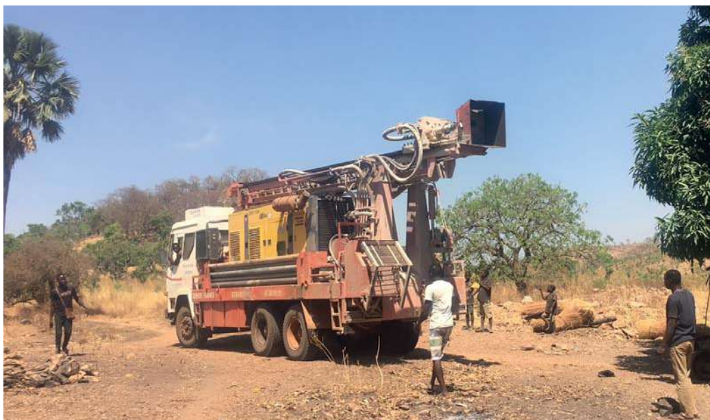
I lavori per la realizzazione del pozzo a Matoukou in Bénin
