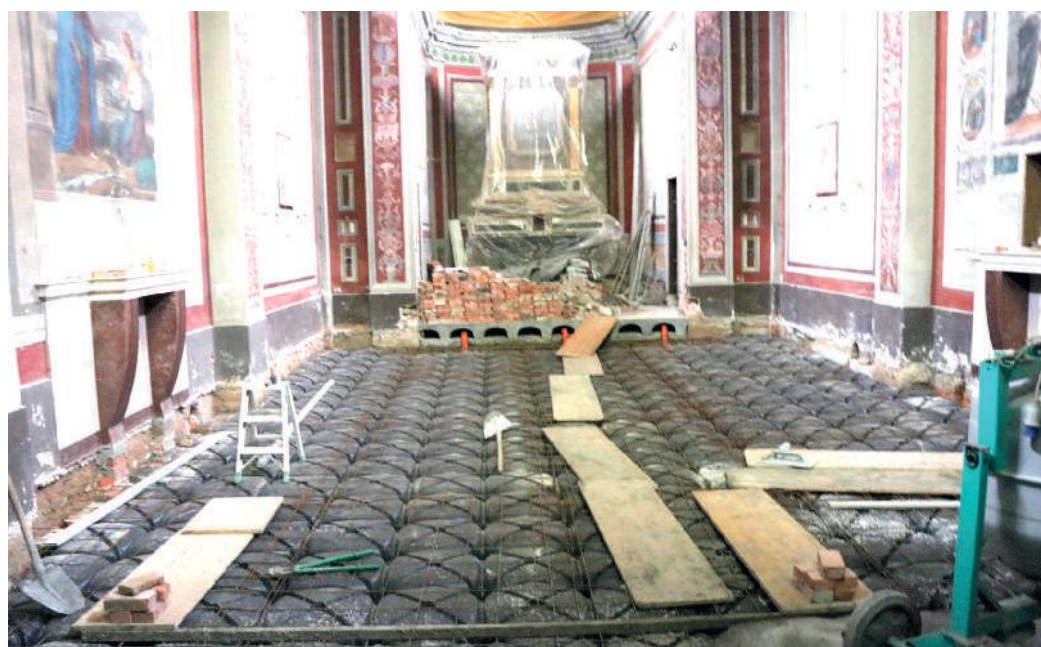
I lavori in corso al santuario della Madonna dei Vignoli (foto Volonterio)
