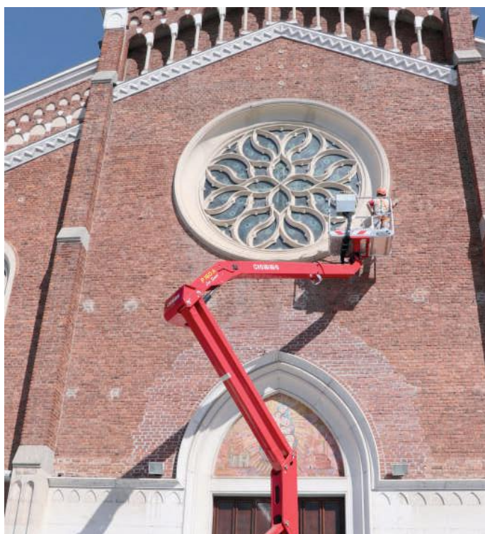
I lavori sulla facciata del santuario
