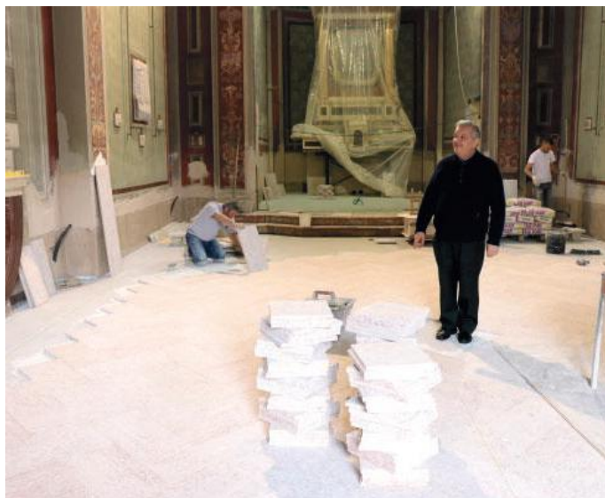
I lavori di pavimentazione ai Vignoli
