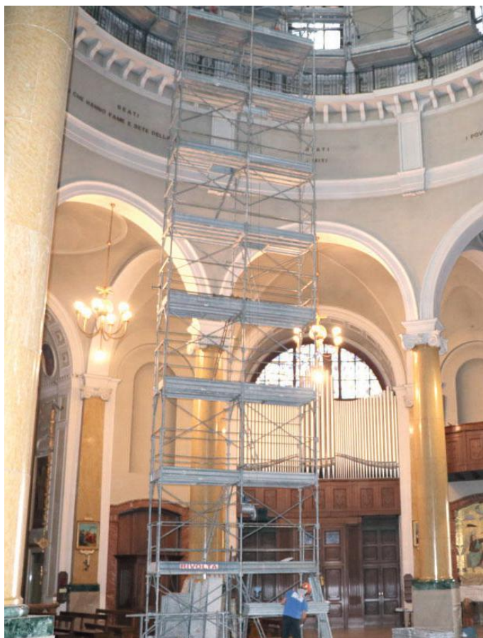
Il ponteggio allestito per i lavori sulla cupola
