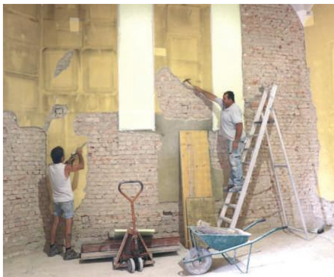
Al lavoro sulle pareti della cappella
