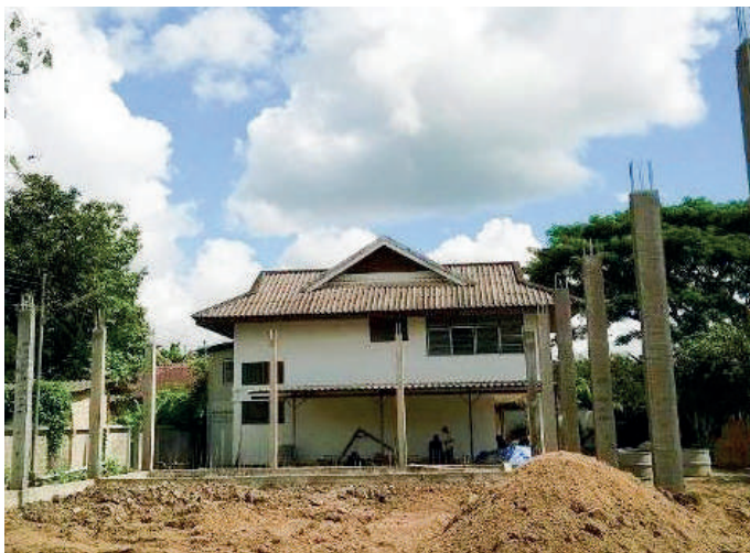
Il centro polifunzionale del Pime in costruzione
