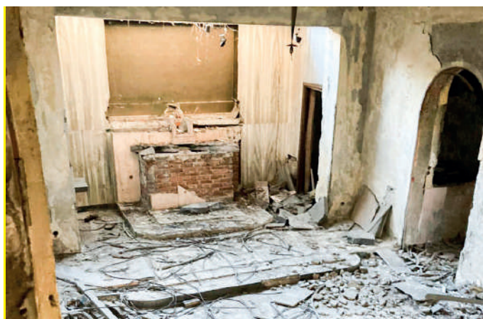
Quello che resta dell'altare della cappella
